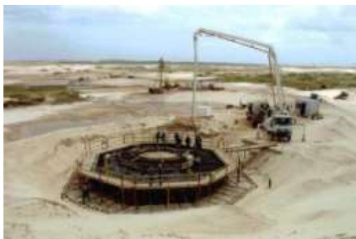
Concretagem de fundação
